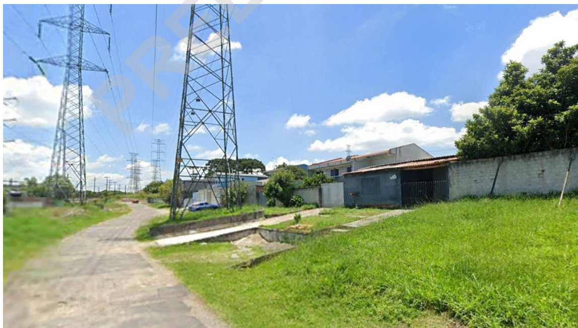
Figura 58: Ocupação Irregular em Faixa de Servidão e Área não edificável de Linha de Transmissão (Cristan)
