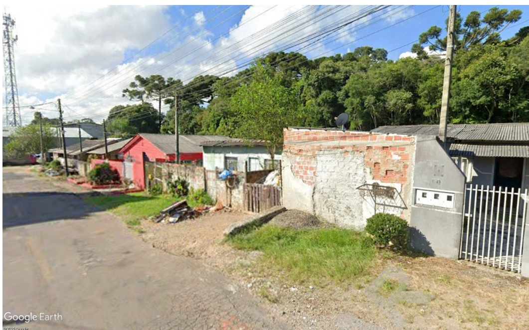
Figura 59: Ocupação Irregular em área pública (Jardim Regência – R. João Palu)
